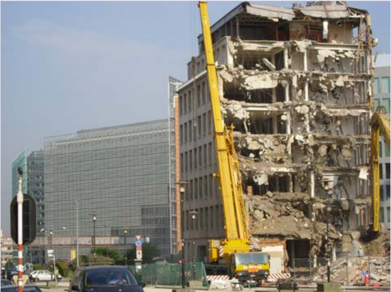
Abriss des JECL
